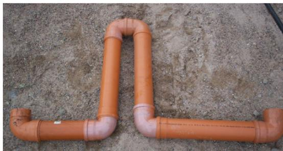
9. Legen sie mit den in der Beschreibung benötigten KG-Elementen das Knickgelenk und schieben Sie die verschiedenen Bauteile ineinander.
